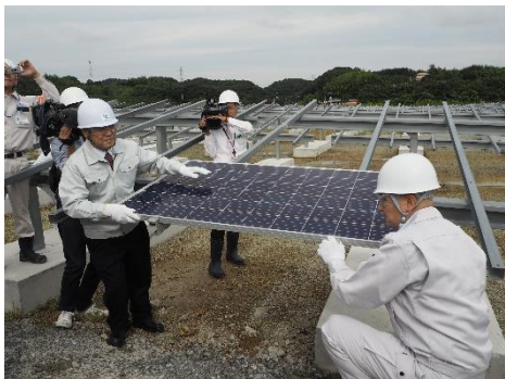
太陽光パネルを架台に設置
