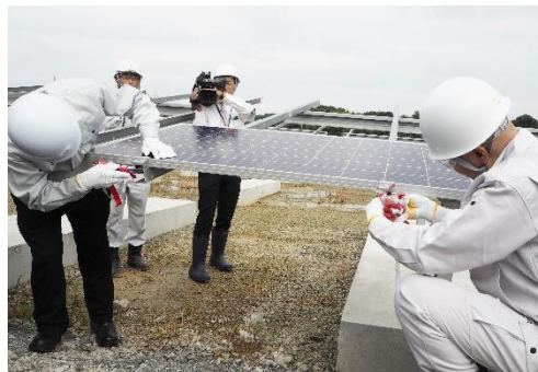
取付金具のボルト締め太陽光パネルを架台に固定
